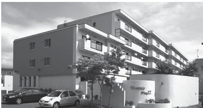
このプロジェクトは築 14 年経過した分譲マンションの長期優良住宅先導事業に組みこまれた外断熱化改修工事です。外断熱工法は、近年比較的普及している工法であり、寒冷地建築には最適な工法と考えられ今後の普及が望まれています。本建物は 3 方をガルバリウム角波鋼板による乾式工法でバルコニー側は湿
