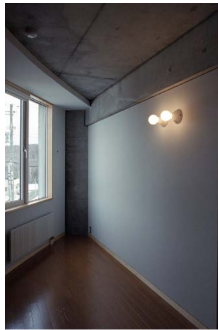
2階子供室、右の白い壁部分が簡易に撤去できます。
